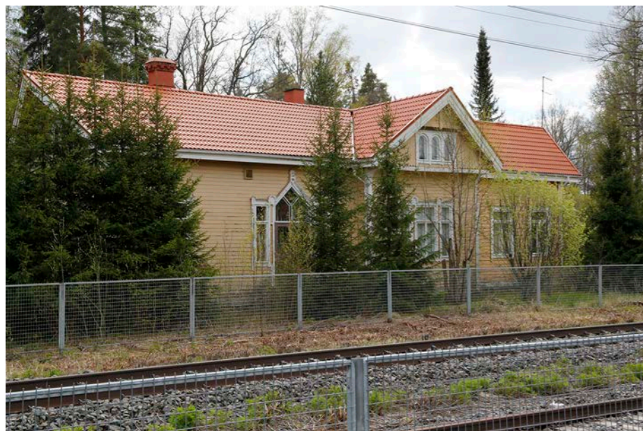
Kuva 14.10 Littoisten asema raiteiden yli kuvattuna.
