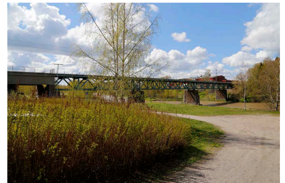
Kuva 14.12 Paimionjoen ylittävä rautatiesilta.
