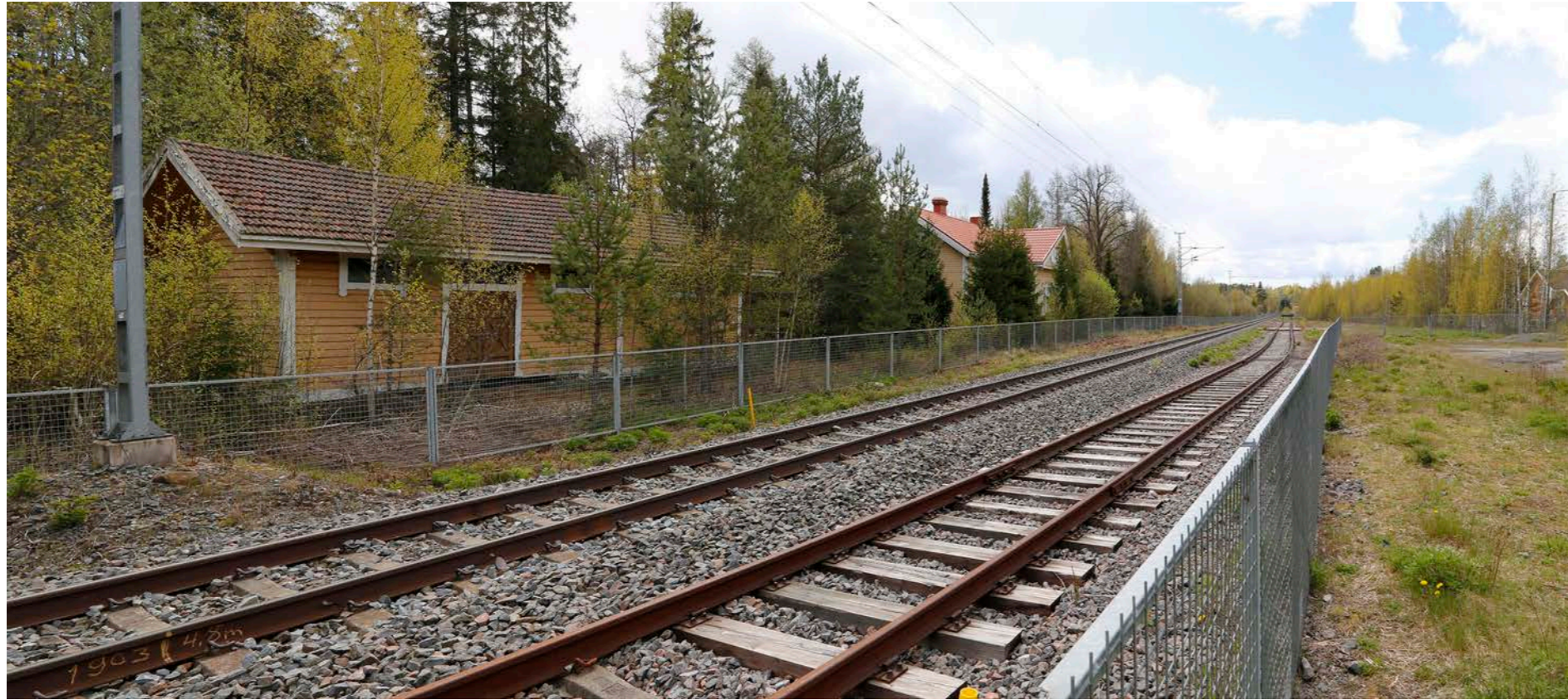
Kuva 14.30 Littoisten asemaympäristöä rautatien pohjoispuolelta lounaan suuntaan kuvattuna.
