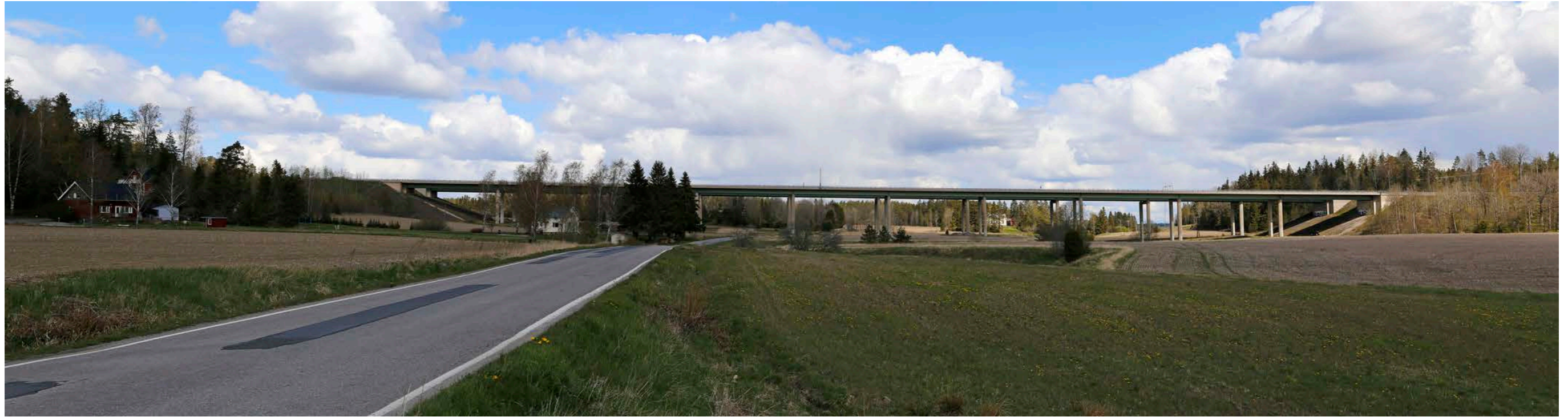
Kuva 14.54 Panoraamakuva Hepojoentielta Turku–Paimio-moottoritien eteläpuolelta kohti pohjoista.
