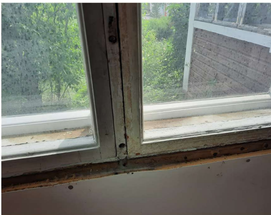
Päärakennuksen vanhoja ikkunoita.
