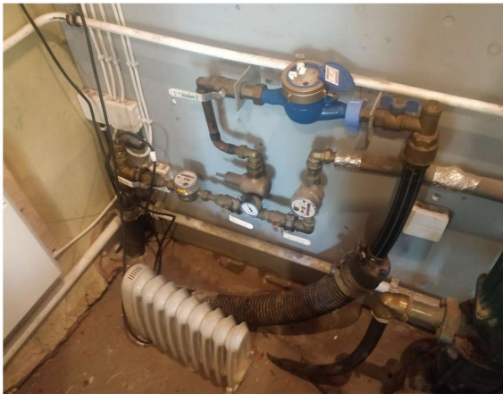
Päävesimittari.
