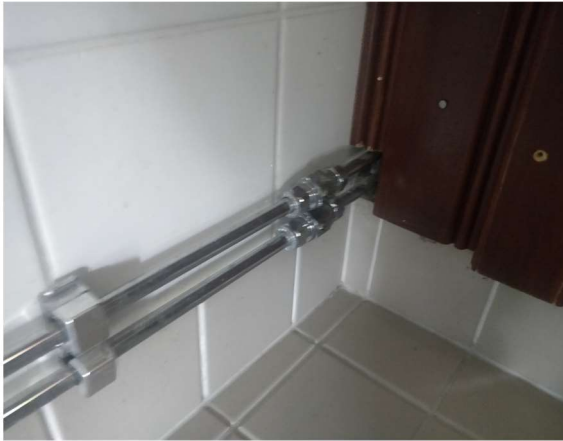
Uusittuja vesijohtoja.
