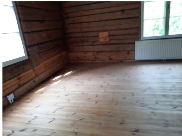
Päärakennuksen kunnostettua lattiaa.
