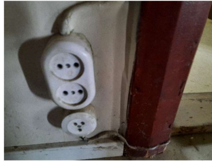
Maadoittamaton pistorasia.
