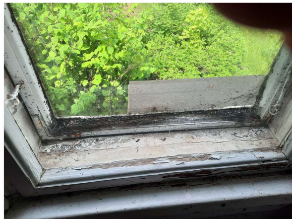
Päärakennuksen vanhoja ikkunoita.
