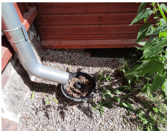
Päärakennuksen sadevedenohjausjärjestelmää Päärakennuksen sadevedenohjausjärjestelmää
