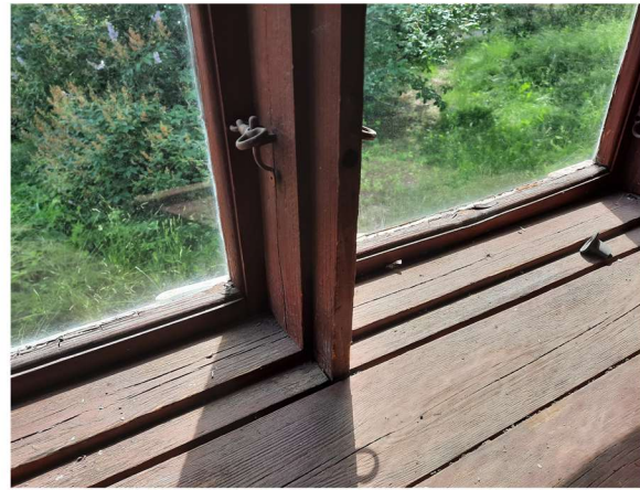
Päärakennuksen vanhoja ikkunoita.
