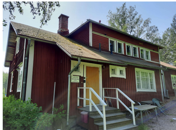
Päärakennuksen toinen sisäänkäynti.
