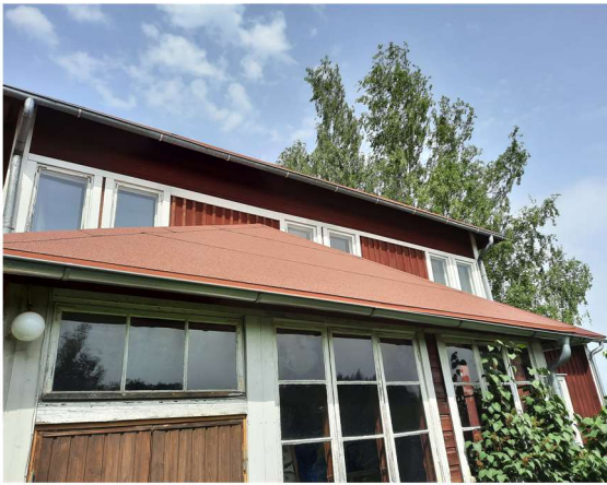
Päärakennuksen vanhoja ikkunoita.
