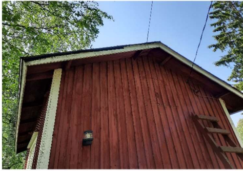
Pienemmän rakennuksen sähköliittymä
