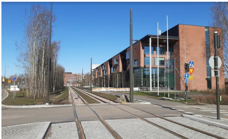
Kuva: Open Innovation House OIH idästä päin kuvattuna.
