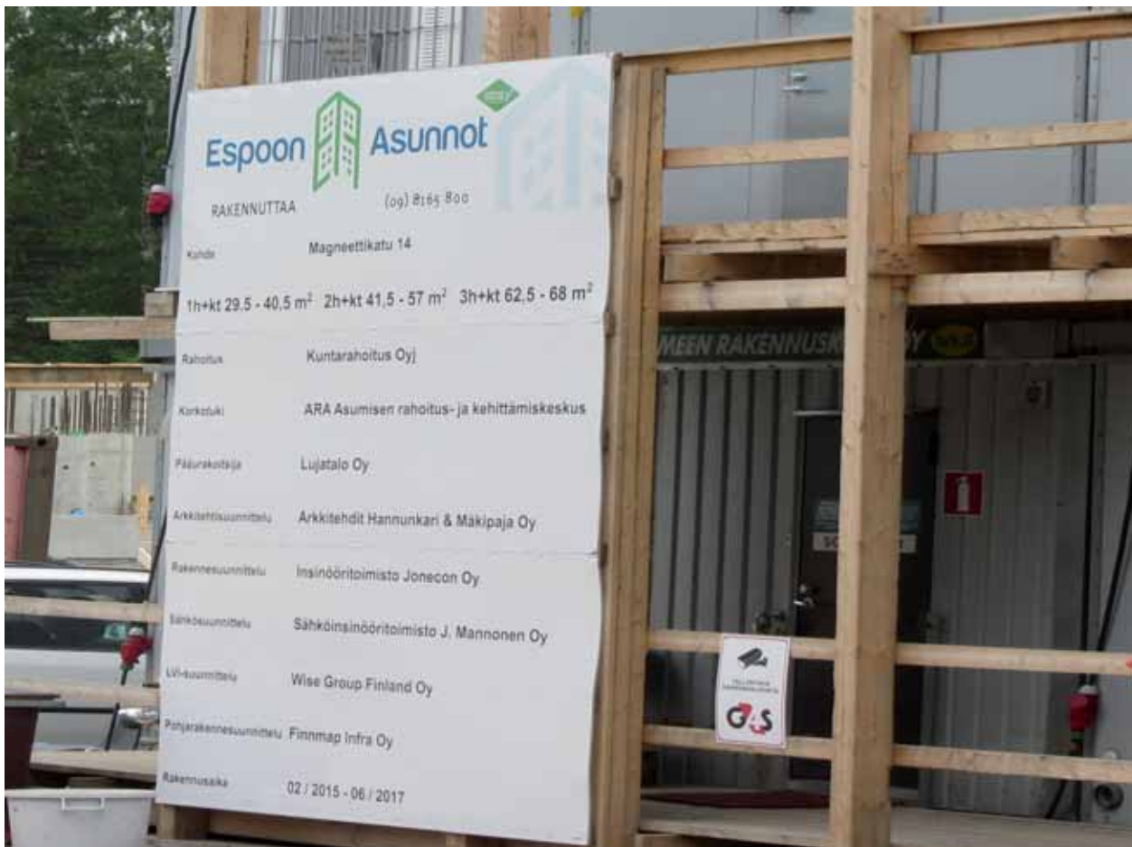
Kuva 14. Espoon Asunnoilla on rakenteilla 115 uutta asuntoa Saunalahteen
