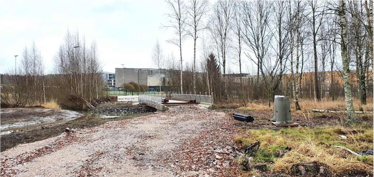
Valokuvassa kaava-alueen itäosan pohjoisreunaa rakenteilla olevalta Storhemptinsillan ulkoilureitiltä. Taustalla näkyy Opinmäen koulu (tilanne 11/2021).
