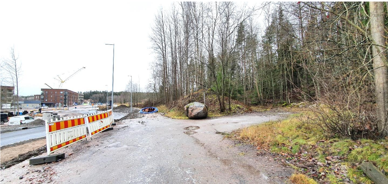
Valokuvassa Storhemptintieltä etelään näkyy kaavanmuutosalueen länsiosan entistä hiekkakuopan aluetta ja Storhemptintien kadunrakennustyömaa. Taustalla Lillhemptinkuja 2:n punatiilisiä kerrostaloja (tilanne 11/2021).
