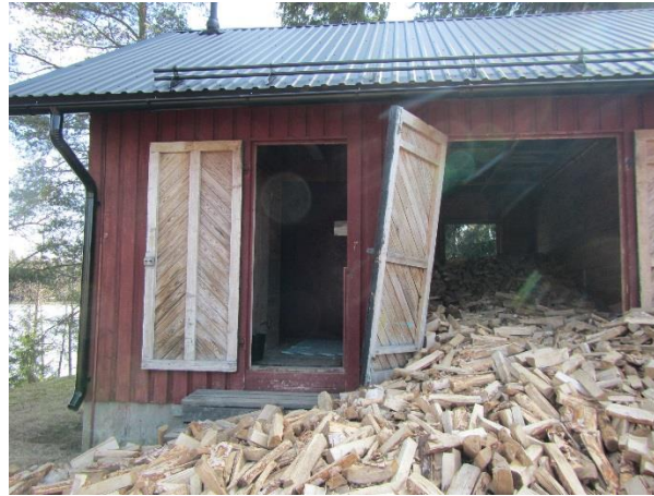
Kuva 57. Yksi ladon ovi on irronnut yläsaranastaan.
