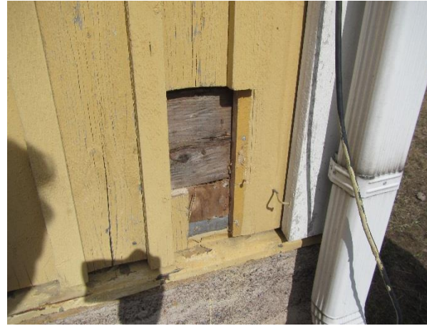
Kuva 40. Rakennuksen eteläpuolelle tehdyssä avauksessa toiseksi alimman hirren kunto oli silmämääräisesti hyvä.
