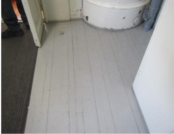
Kuva 86. Eteistilassa on maalattu lankkulattia
