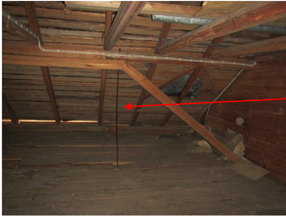
Kuva 65. Katon alkuperäiset kantavat puurakenteet.
