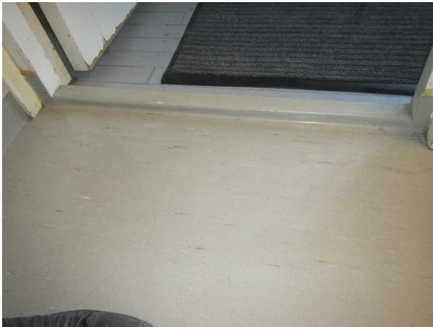
Kuva 92. wc:n kynnys on nostettu oikeaoppisesti
