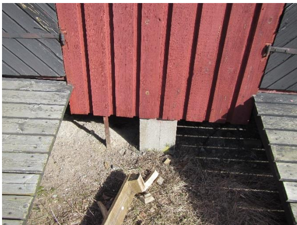
Kuva 18. Piharakennuksen betonipaalu.
