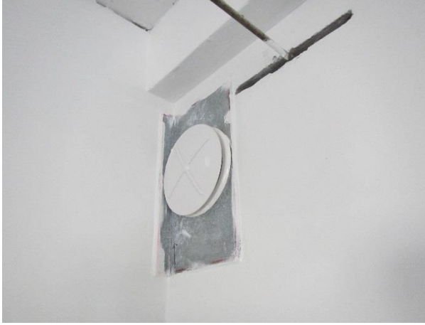
Kuva 121. Poistoilmaventtiili asennettuna pystyhormissa olevaan sinkittyyn peltikanavaan
