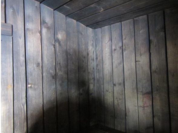
Kuva 79. Saunan paneelit ovat tummuneet käytössä
