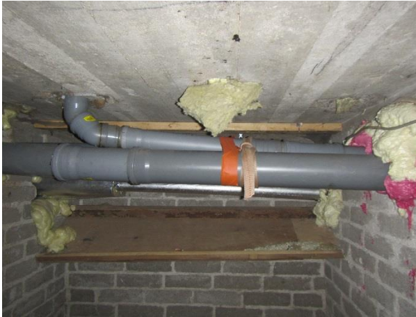
Kuva 114. Kellaritilassa olevia jätevesiviemäreitä
