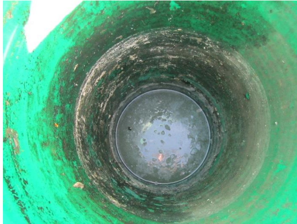
Kuva 111. Harmaaavesikaivo, josta vesi imeytetään maaperään
