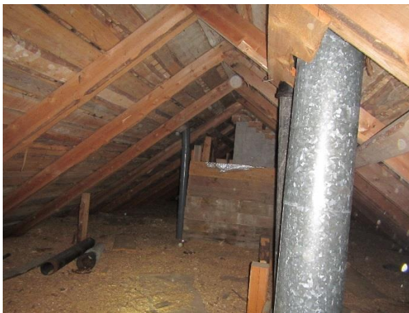
Kuva 119. Eristämätön ullakkotilassa
