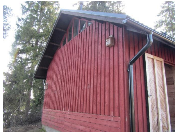
Kuva 48. Piharakennuksen päätyjen yläosissa on lasitus
