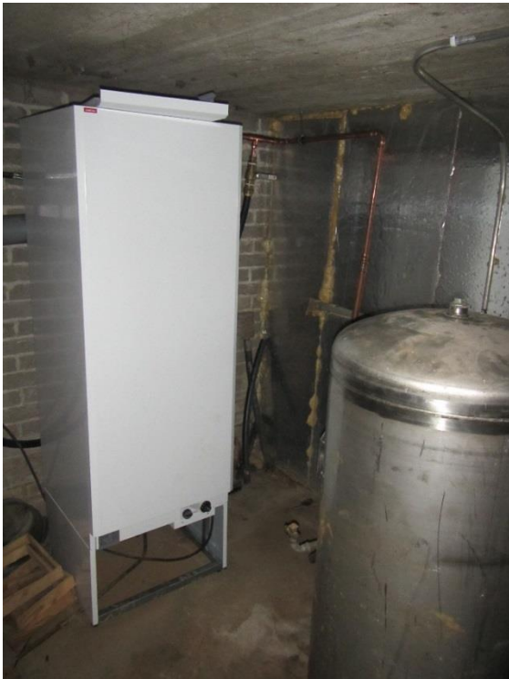
Kuva 96. Lämminvesivaraaja
