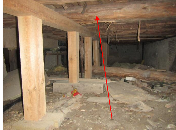
Kuva 27. Rakennuksen etupihan puolella alapohjarakenteisiin on tehty lisätuentaa. Tässä kohtaan alkuperäiset puupalkit olivat lahoja.
