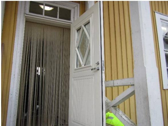
Kuva 58. Ulko-ovi uusittu vuonna 2005.
