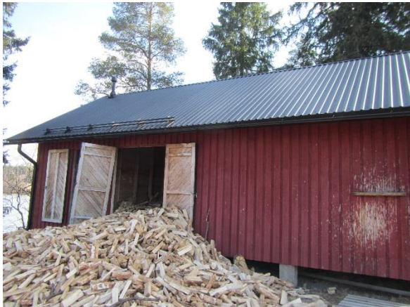
Kuva 64. Piharakennuksen vesikato on uusittu ja hyvässä kunnossa.
