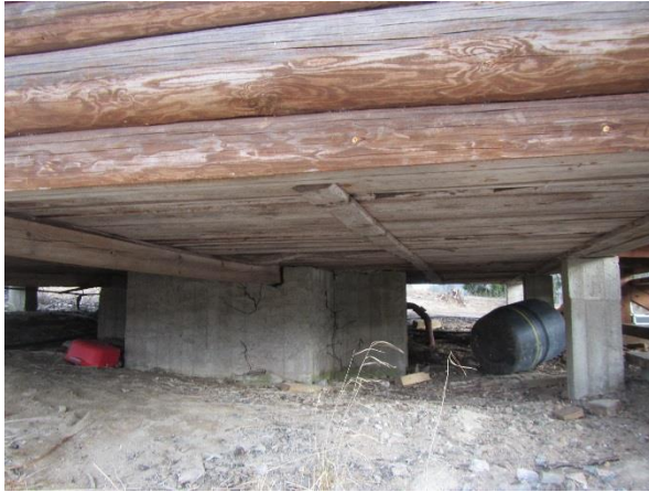
Kuva 16. Saunarakennuksen betoniset perustukset.
