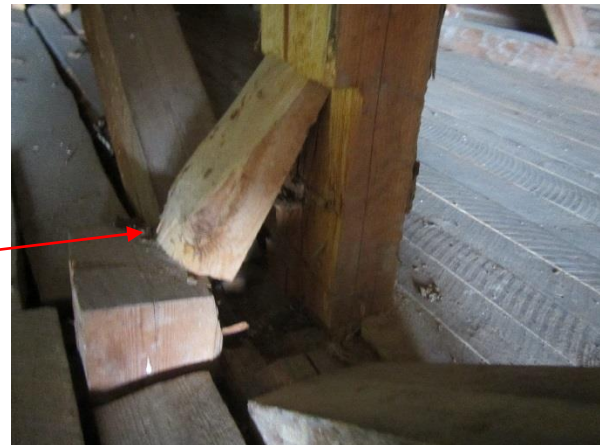
Kuva 68. Siirtyneen tukiparrun alapuolelle tehty lisätuentaa.
