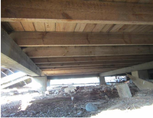
Kuva 24. Alapohjan rakenteet silmämääräisesti hyvässä kunnossa.
