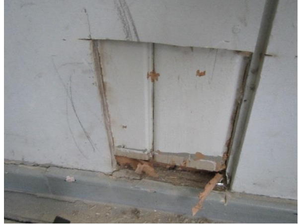
Kuva 81. Lujalevyn takana on vanha puupanelointi
