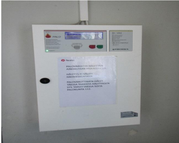
Kuva 140. Näkymä palovaroitin- ja turvavalokeskus
