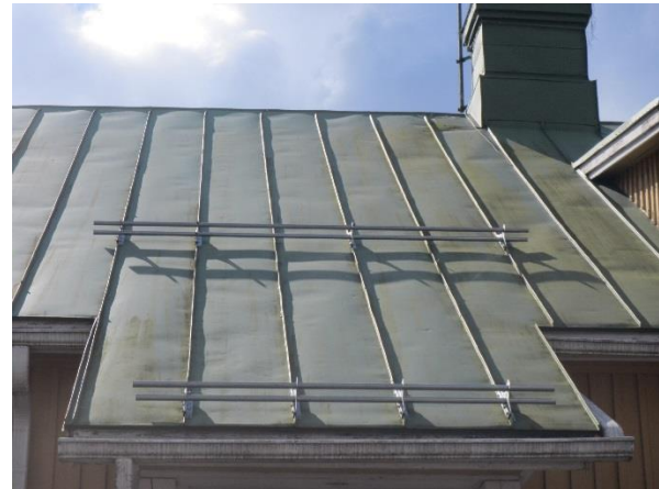
Kuva 72. Vesikatolle on asennettu lisää lumiesteitä jään kertymisen vuoksi.
