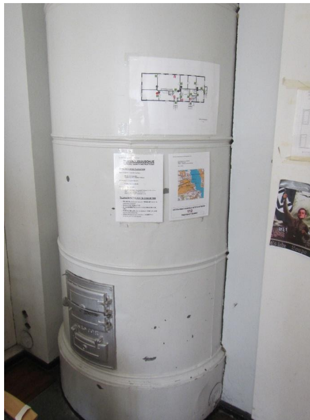
Kuva 94. Päärakennus on aikoinaan pidetty lämpimänä kuvassa näkyvän kakluunien avulla, mutta nykyään ne ovat poistettu käytöstä
