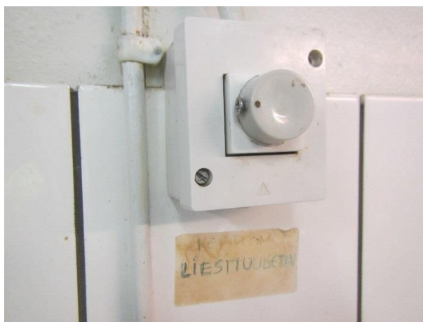
Kuva 118. Liesituulettimen tehonsäädin
