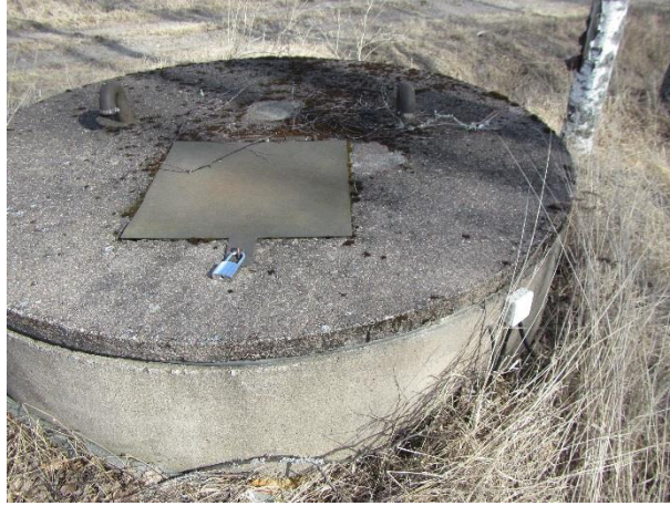
Kuva 105. Vesikaivon tarkastusluukku on lukittu asianmukaisesti
