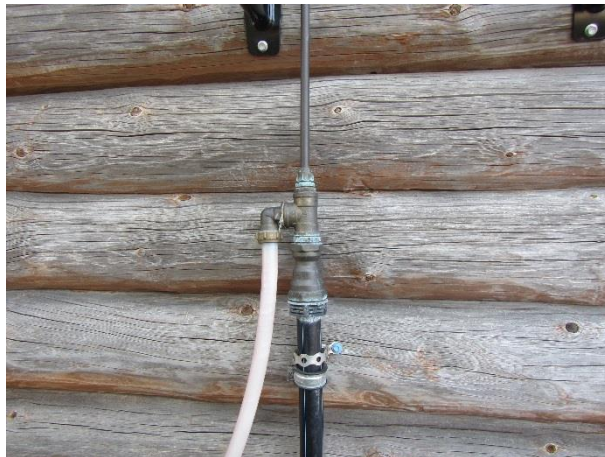
Kuva 103. Saunarakennukselle tuleva päävesijohto
