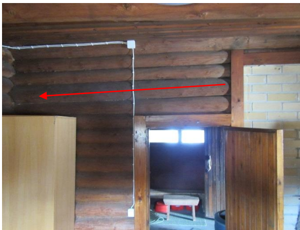
Kuva 37. Hirsirunko on hieman painunut ajansaatossa.
