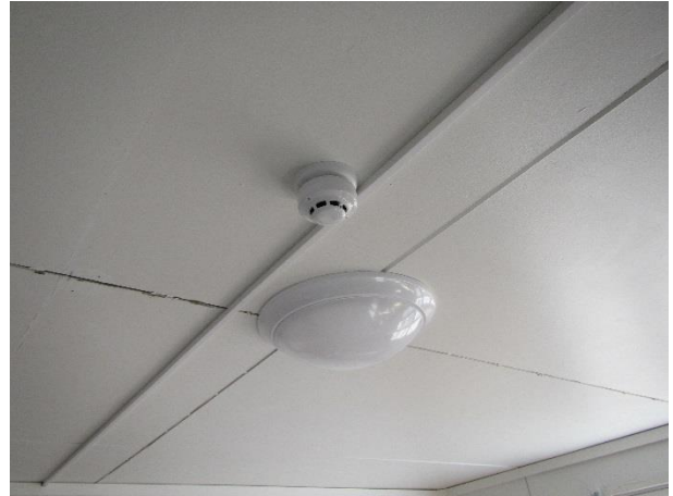
Kuva 134. Päärakennuksen valaistus ja palovaroitin.
