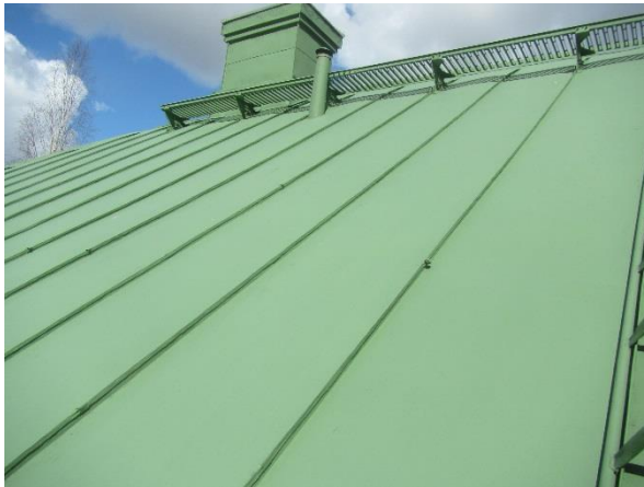
Kuva 71. Vesikaton maalipinta on hyvässä kunnossa.
