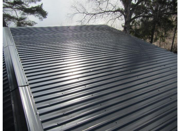
Kuva 63. Vesikatto on uusittu noin 10v sitten ja se on yleisesti hyvässä kunnossa.
