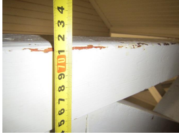
Kuva 76. Kaiteen korkeus ylimmän tasanteen kohdalla 720mm.
