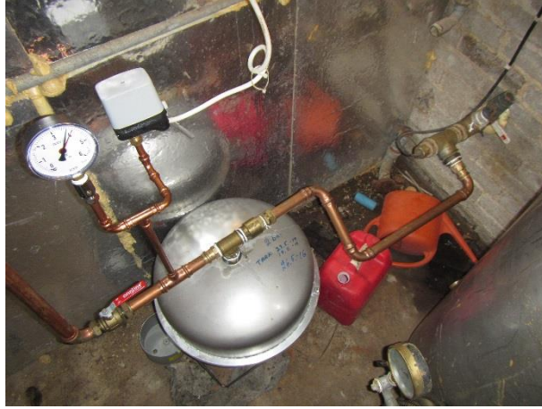
Kuva 101. Painevesisäiliö on tarkistettu/puhdistettu viimeksi 26.5.2016
