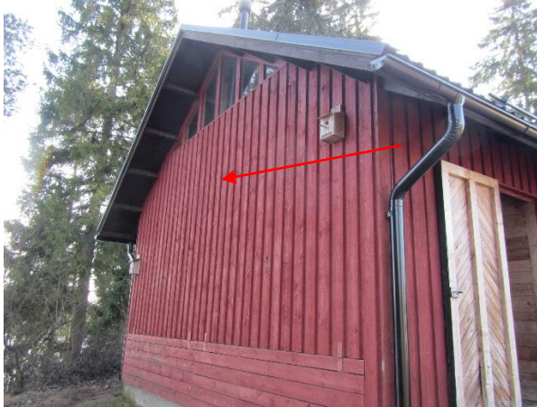
Kuva 41. Piharakennuksen julkisivut ovat hyvässä kunnossa.
