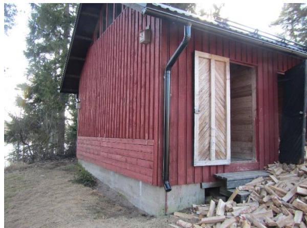
Kuva 19. Piharakennuksen takaseinustalla betonisokkeli.
