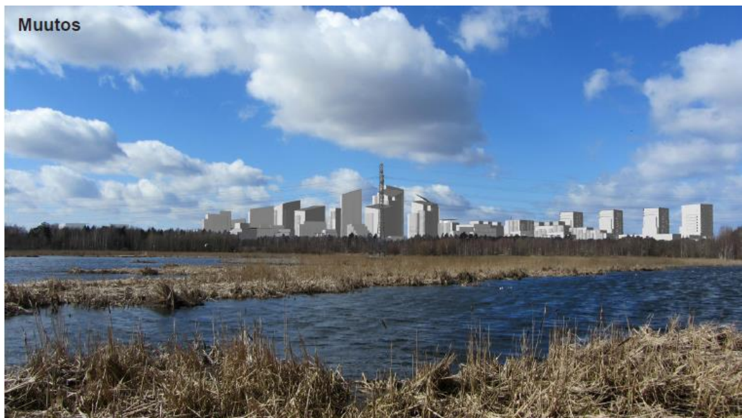
Kuva 34: Näkymä lintualtaan itäreunalta.
