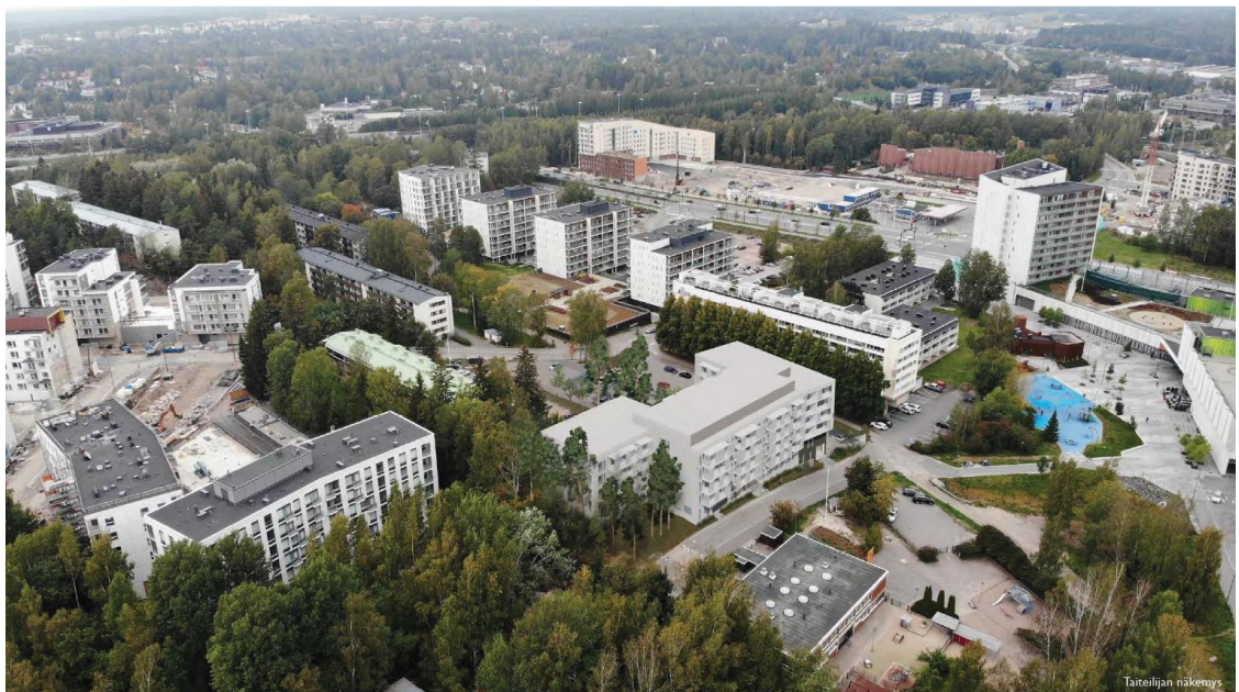
Kuva 24 Ilmakuvasovite kaavan mukaisesta rakentamisesta kaakosta käsin. Kuva: Konkret 2022.
