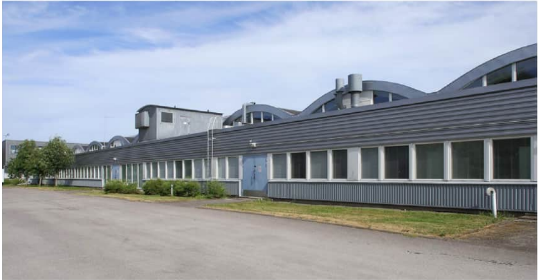
Kuva 17. Kaarihallien luoteeseen aukeava julkisivu vuonna 2018. (Kuvälähde: ark-byroo, 2019)
