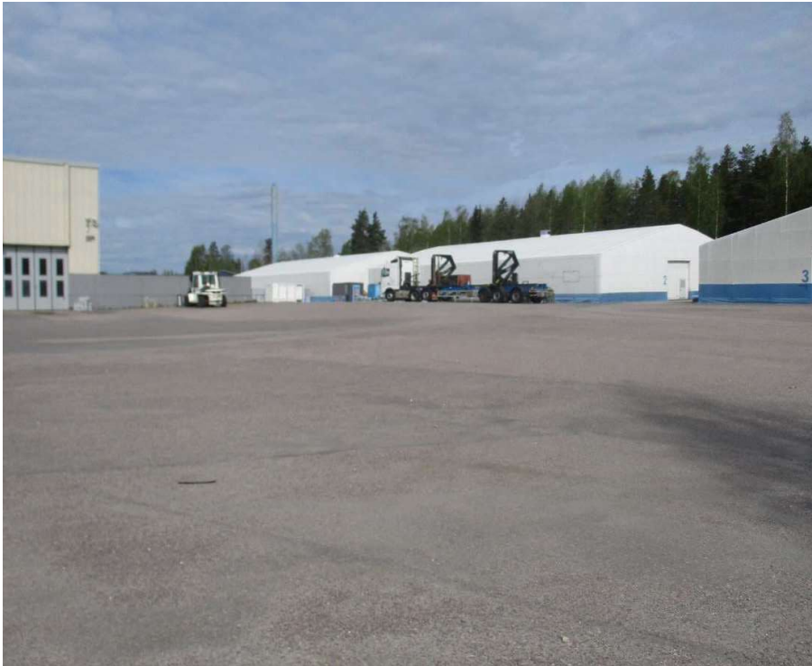
Kuva kohteen sisäpihalta. Kuvassa hallit 1 & 2 sekä osa hallin 3 päätyä.
