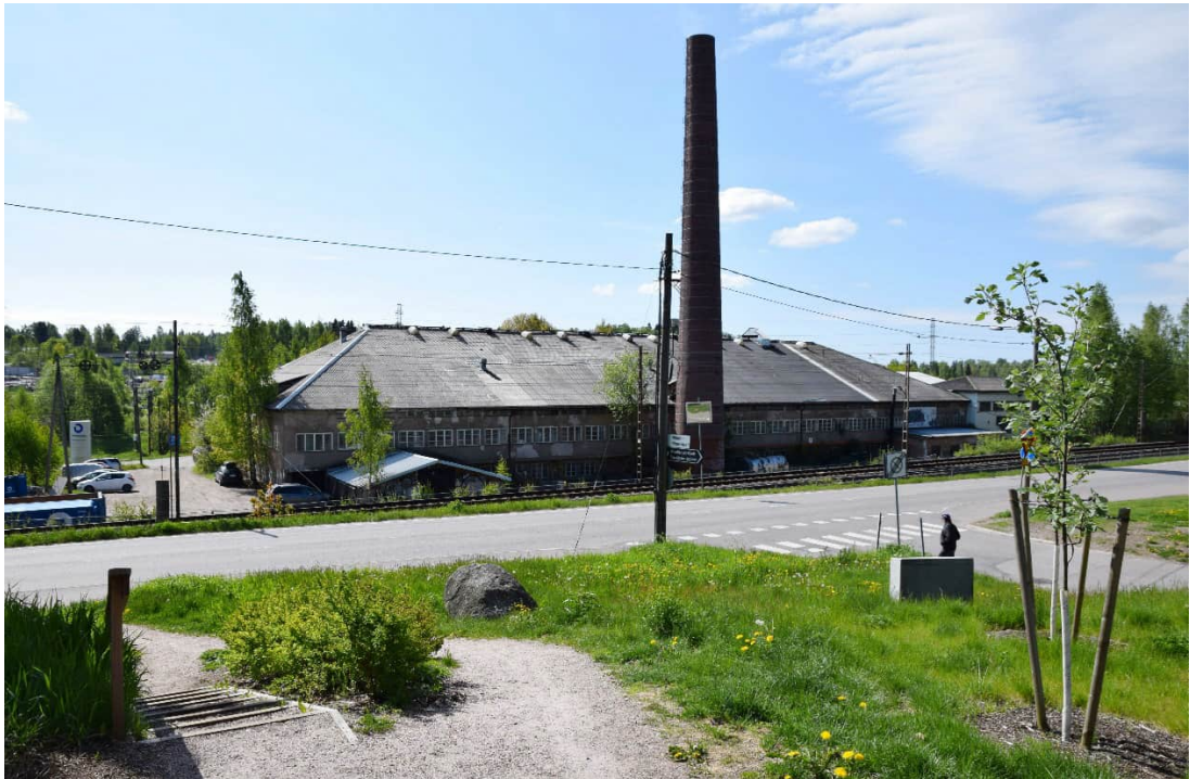
Kuva 15. Lasitehdas kuvattuna radan pohjoispuolelta vuonna 2016. Etualalla oleva vanha maamerkinmäinen tiilisavupiippu on jo purettu ja korvattu uudella piipulla. (Kuvälähde: Espoon kaupunginmuseo, 2016)
