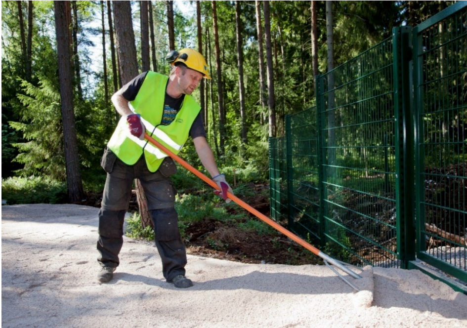
Kuva 15. Uutta koira-aitaukselle vievää kivituhkaraittia viimeistellään. (Espoon aineistopankki)
