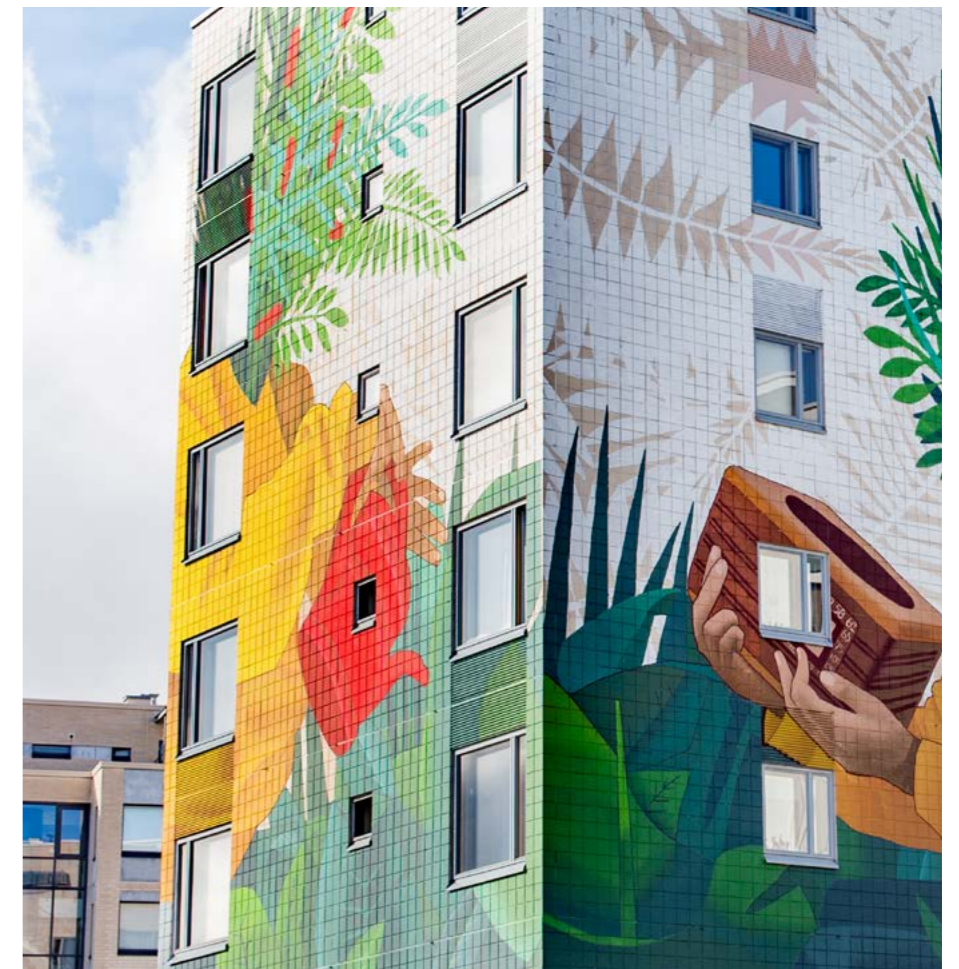
2– Paikkaan sopiva seinämaalaus voi muuttaa tavallisen julkisivun nähtävyydeksi, kuten Matinkylässä UPEA -kaupunkitaidefestivaalin puitteissa tapahtui.
