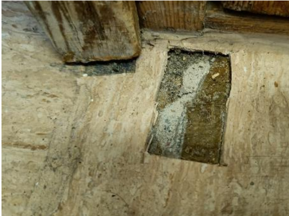
Kuva 89 Näyte 5. Märkäeteisen 1.35 beige muovimatto. Ei sisällä asbestia. Sisältää raskasmetalleja.
