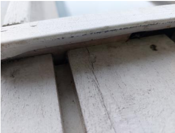
Kuva 17 Ikkunapellit ulottuvat riittävän kauas laudoituksesta.
