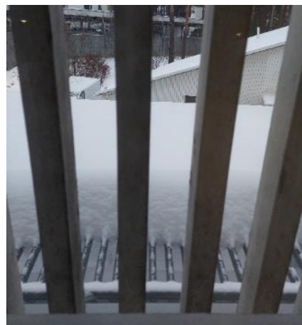
Kuva 37 Yläikkuna on hieman vesikaton yläpuolella.
