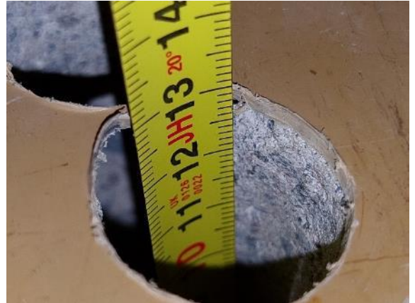
Kuva 27 Aukon kokonaissyvyys oli 130 mm.
