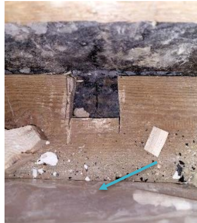
Kuva 33 Alaohjauspuun alla on bitumikerros. Muovi jatkuu alaohjauspuun alapuolelle.
