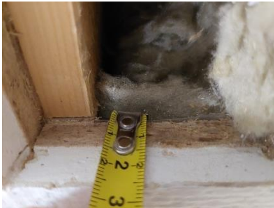
Kuva 58 Rakenne oli sisäpinnasta lukien kipsilevy 15 mm, puulevy 10 mm ja läpinäkyvä muovi.
