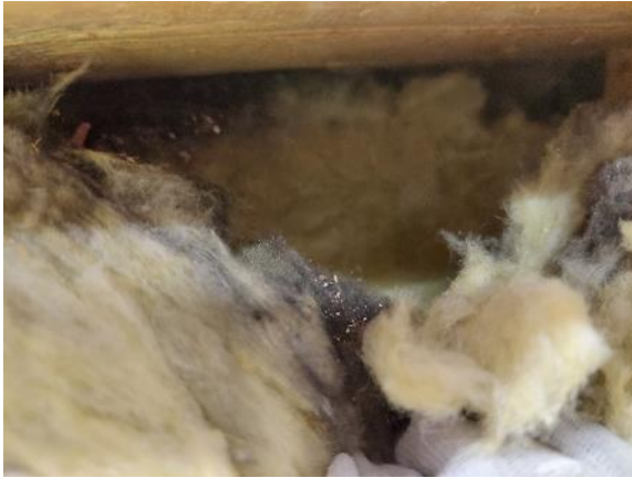
Kuva 50 US10 eristetilassa oli tummentumia.
