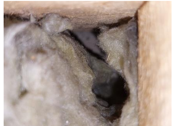
Kuva 59 Eristevillasta otettiin näyte. Avauksen kokonaissyvyys oli 195 mm.
