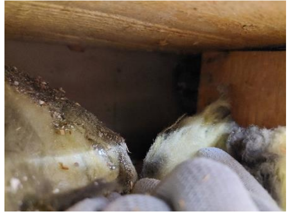
Kuva 51 Tuulensuojalevy näkyy villaeristeen takana.
