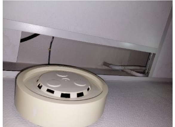
Kuva 78 Alaslaskussa on putkia, jotka olivat nyt kuivat.
