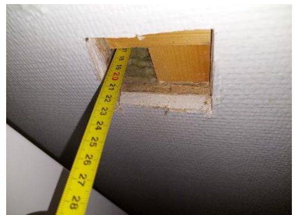
Kuva 61 Avauksen kokonaissyvyys oli 195 mm. Avaus tehtiin 820...880 mm korkeudelle lattiasta.
