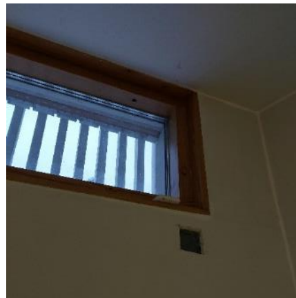
Kuva 35 US3 eteishallin 1.56 yläosaan yläikkunan alle.
