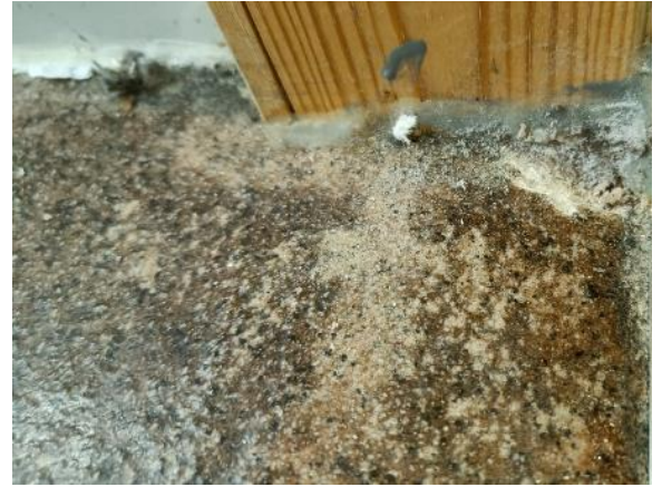
Kuva 90 Näyte 6. Keittiön 1.02 akrylibetoni. Ei sisällä asbestia.
