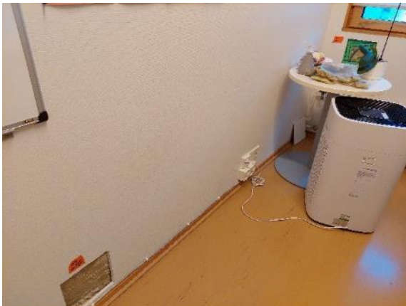
Kuva 70 Väliseinän avaus VS3 johtajan tilaan 1.07. Ta-kana on keittiön varasto, jossa on koettu ma-ellarimaista hajua.
