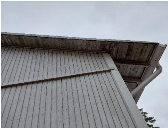
Kuva 11 Rästäävät ovat pitkät sivuseinillä, päädyissä räystäät ovat kapeammat.
