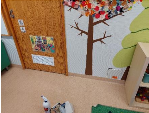
Kuva 68 Väliseinän avaus VS1 tilaan 1.73.
