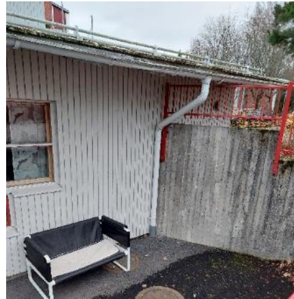
Kuva 10 Julkisivulaudoitus ulottuu melkein maahan asti lounaiskulmalla. Sadevesi johdetaan syöksytoria pitkin sadevesijärjestelmään.
