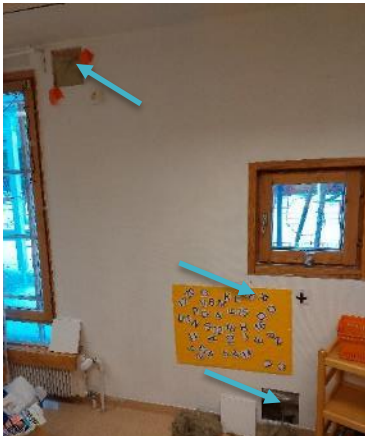
Kuva 44 US7, US8 ja US9 tilaan 1.36. Pikkuikkunan alapuolista avausta ei ollut vielä tehty kuvaushetkellä.
