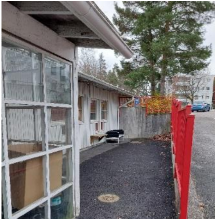
Kuva 9 Rakennuksen 1 lounaiskulma. Talon päädyssä oleva parkkipaikka on muuta pihaa korkeammalla.
