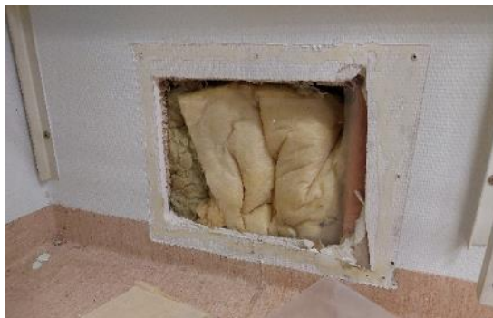
Kuva 30 US1 nukkariin 1.72 vanhan rakenneavauksen kohdalle. Avaus oli 90 mm korkeudella lattiasta.
