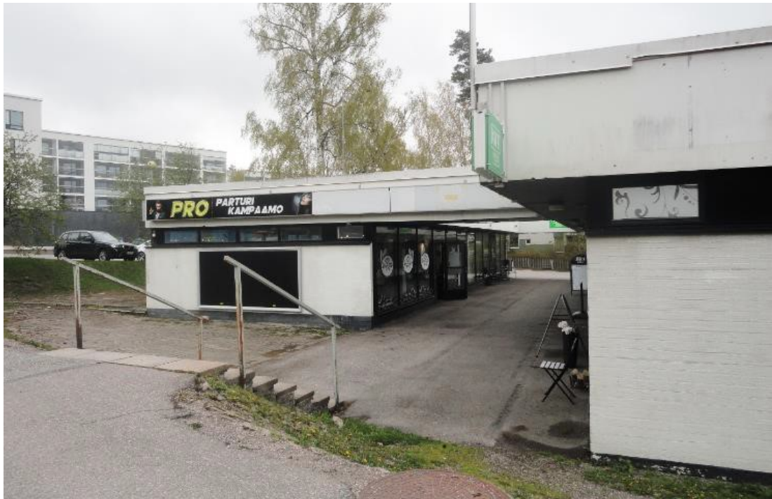
Kuva 60-luvun ostoskeskuksesta ja sen edessä olevasta pienestä aukiosta. Aukion alkuperäinen merkitys edustusaukiona on hämärtynyt, kun Haukilahdenkatua on korotettu.
