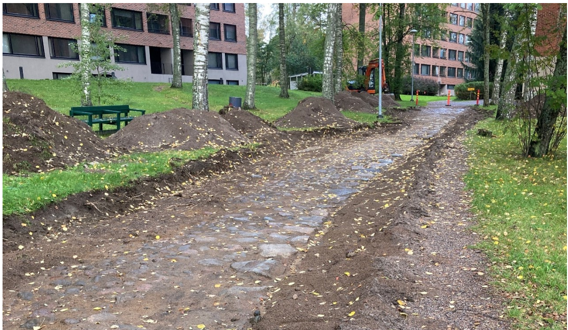
Kuva esiin kaivetusta tykkitiestä syksyllä 2023.
