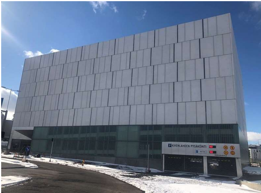
Kivenlahden liityntäpysäköintilaitos otettiin käyttöön keväällä 2023. Kuva: M.Partanen
