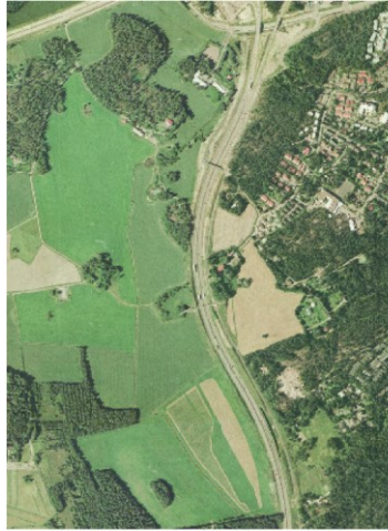
2001: Kehä II valmistui v. 2000. Väylän yli kuljetaan Nygrannaksen ja Möllimäen siltojen kautta. Kartta: Espoon karttapalvelu.
