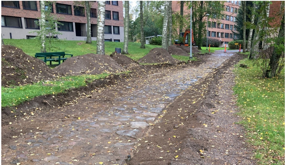
Kuva esiin kaivetusta tykkitiestä syksyllä 2023.
