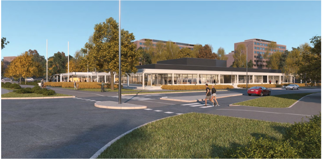
Kevään 2024 kaavaehdotuksen mukainen näkymäkuva, jossa ilmanvaihtokonehuone on sijoitettu katolle. Kuva: Arkkitehtitoimisto Sarc.
