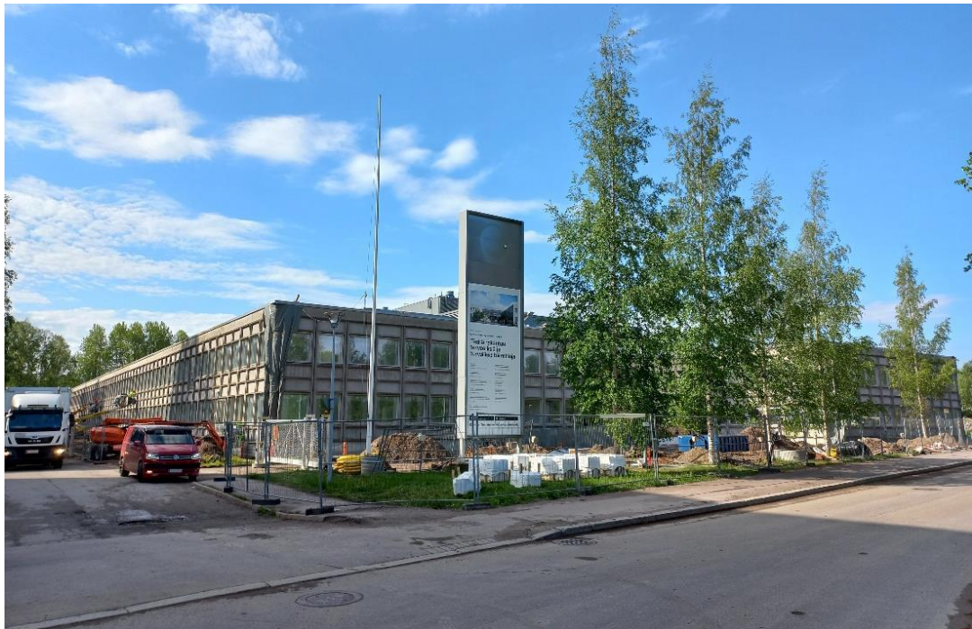
Rakennus kuvattuna pohjoisesta.
