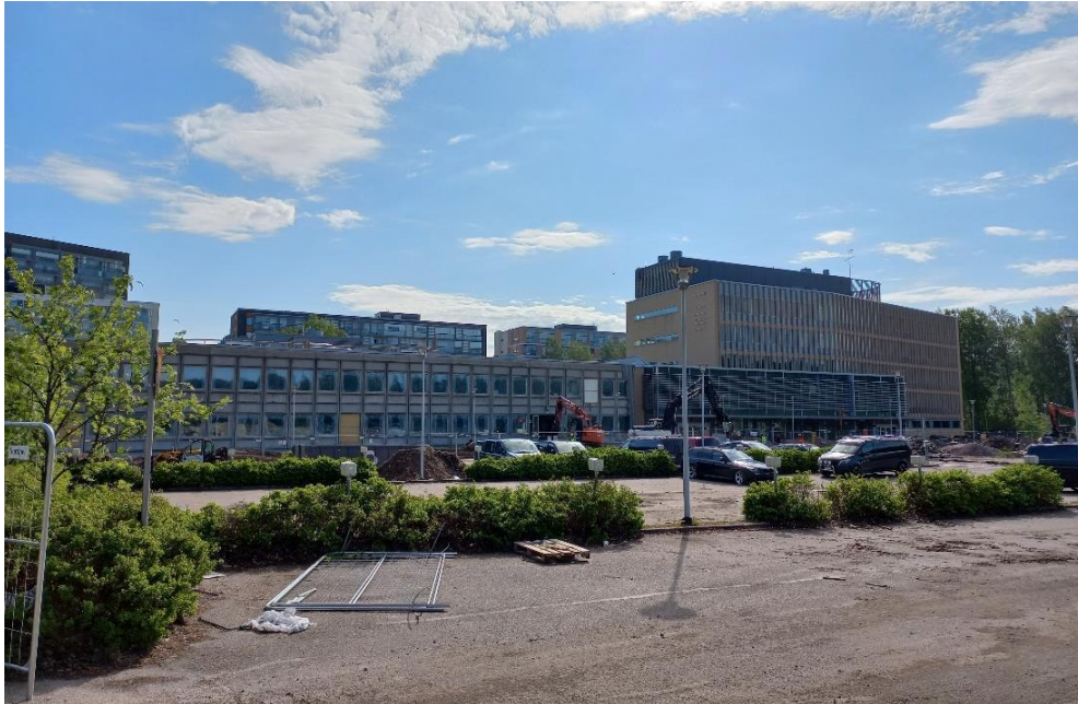
Rakennus kuvattuna lännestä.
