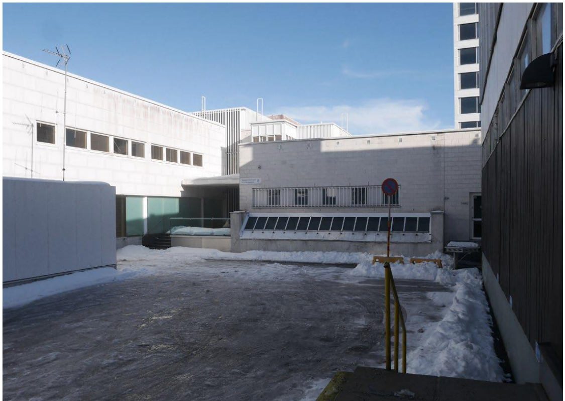
Marimekkotalon ja Tapiontorin liikekeskuksen välissä oleva huoltopiha ja pysäköintialue. Oikealla Tapiontorin liikekeskuksen sulkeutunut, huoltotoimintoja palveleva pohjoinen julkisivu.
