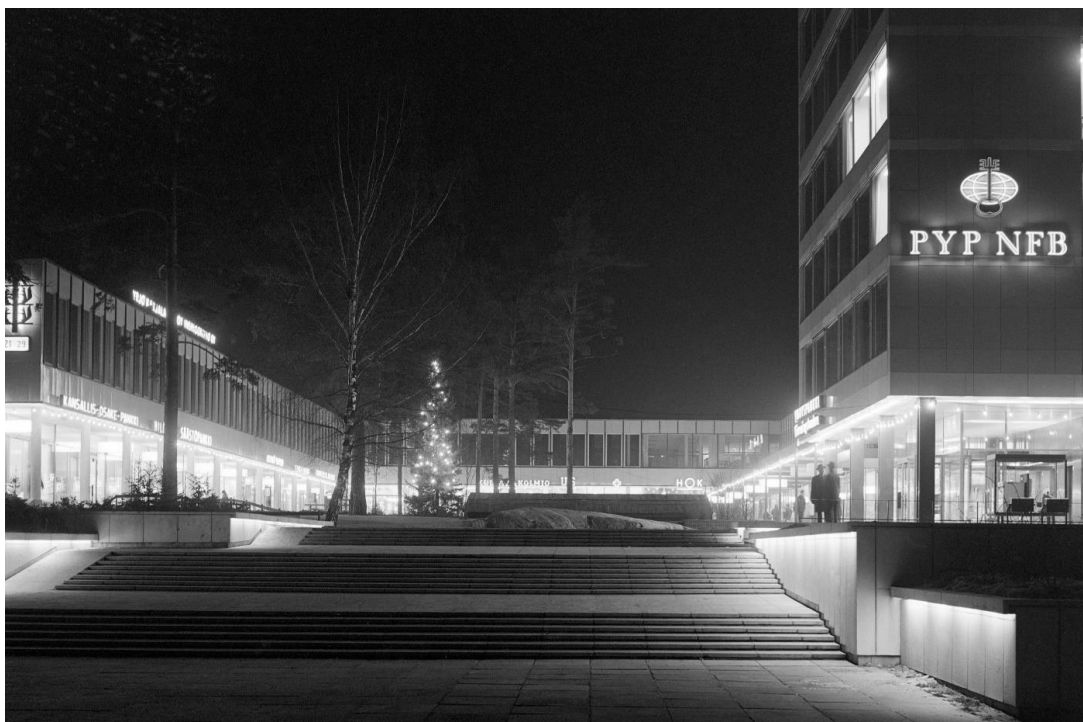
Näkymä Tapiontorin sisäpihalle ja sisäpihan julkisivuja vuonna 1963.
