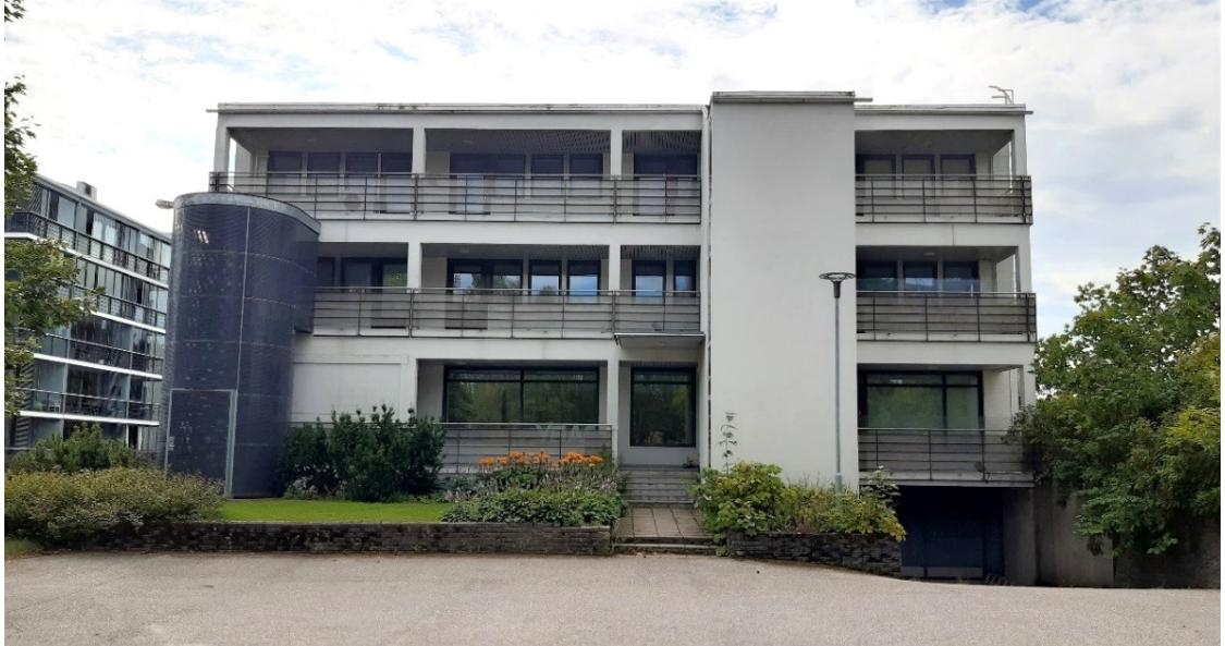
Kuva 2 Suunnittelualueella sijaitseva liikerakennus pohjoisesta kuvattuna.
