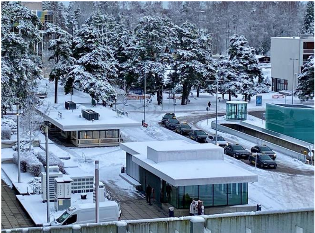
Näkymä Tuulikinsillalle. Etualalla on Keskuspysäköinnin rakennus ja takana infokioski.
