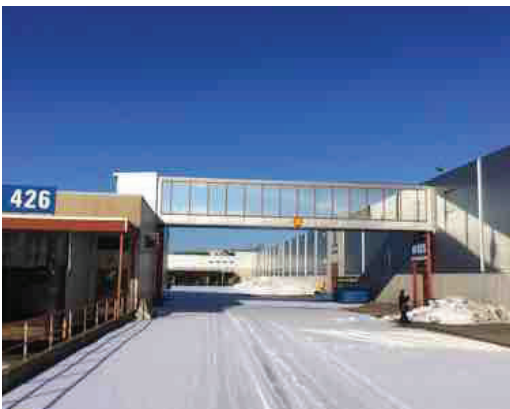
LOGISTIIKKAKESKUKSEN SISÄPIHA (KUVA: B&M)
