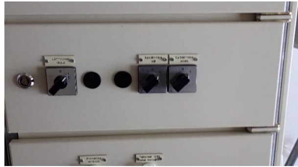
Kuva 42: Lämmityksien ohjauskeskus
