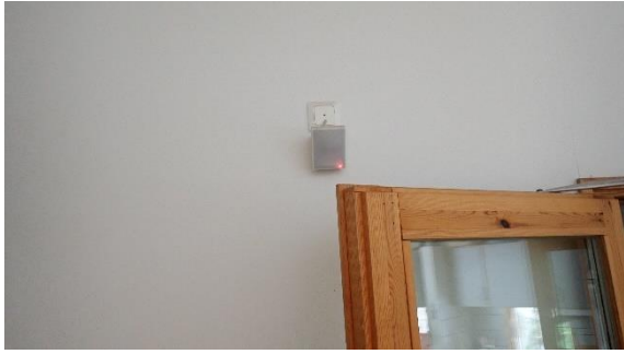
Kuva 57: Murtojärjestelmän liiketunnistin.
