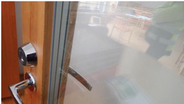
Kuva 11: Pääsisäänkäyntioven ikkuna, lukitus ja armi hyväkuntoiset
