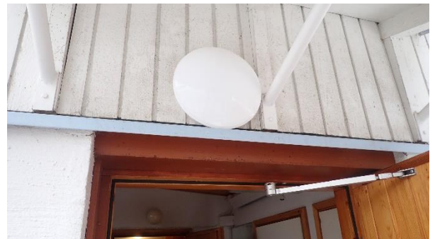
Kuva 40 Saunarakennuksen päätyjen käyntioivissa on yleisvalot
