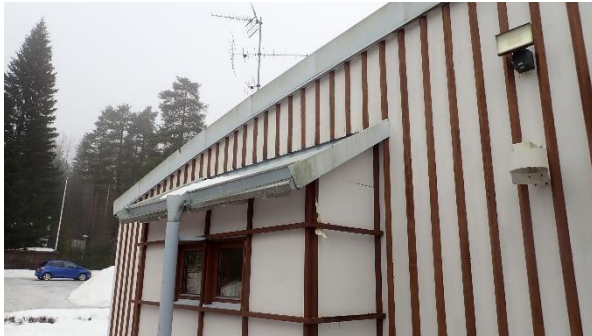
Kuva 5: Huoltorakennuksen julkisivua ja ulokerakenne.
