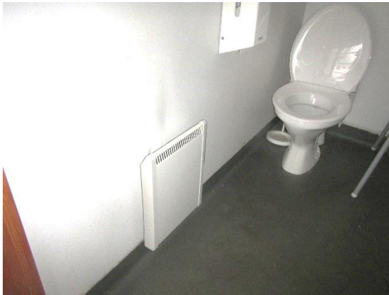
Kuva 27 Sähkötoiminen lämmityspatteri
