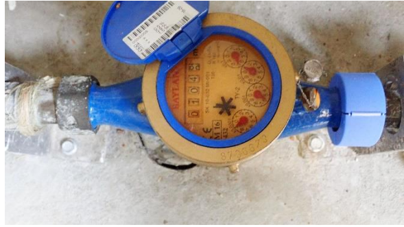
Kuva 31: Päävesimittari.
