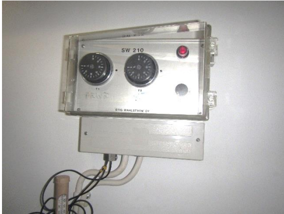
Kuva 29 Lämminvesivaraajan ohjausyksikkö
