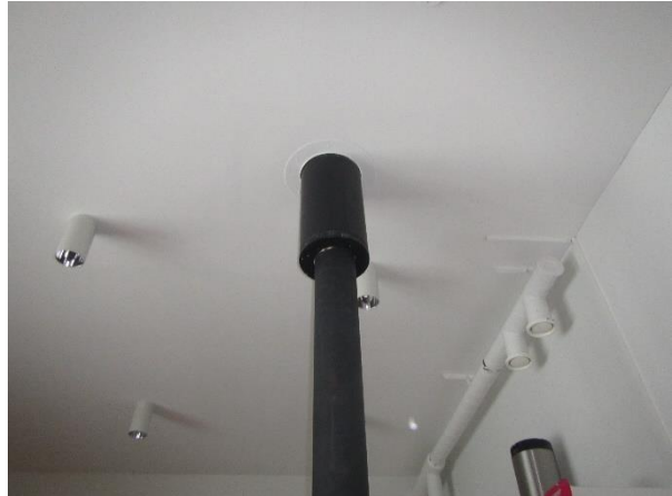
Kuva 38 kuvassa poistoilmakanavistoa sekä takan savupiippu.
