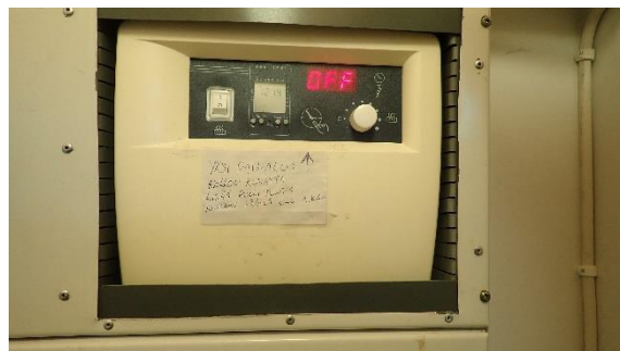
Kuva 52. Kiukaan ohjauskeskuksen lisäajastin
