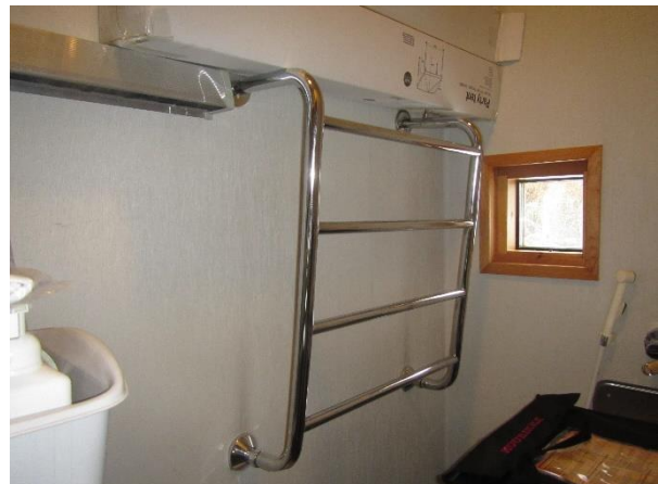
Kuva 31 Siivouskomeron kuivauspatteri
