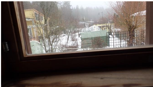
Kuva 9: Ikkunat ovat sisäänpäin aukeavia kaksipuitteisiä puuikkunoita tyyppiä MSE.
