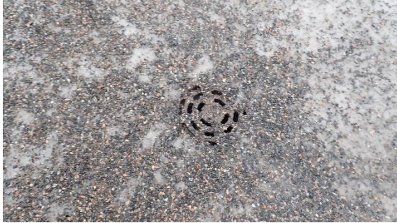
Kuva 36 Sade- tai salaojaviemärin kansi jäätyneenä.
