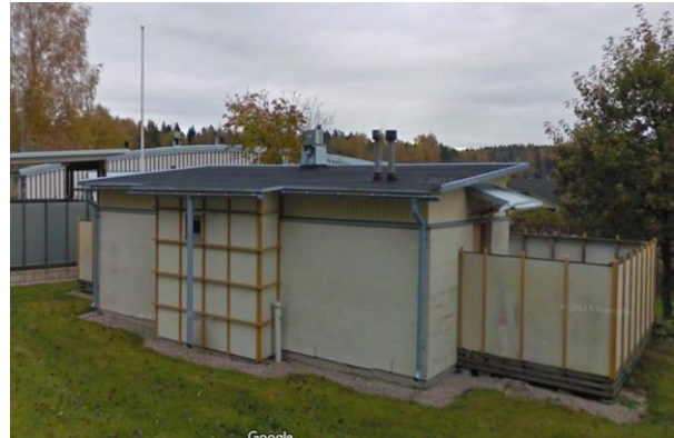
Kuva 6: Saunarakennuksen julkisivu on levyrakenteinen. Päätysten vilvoittelutiat ovat lujilevyrakenteisia
