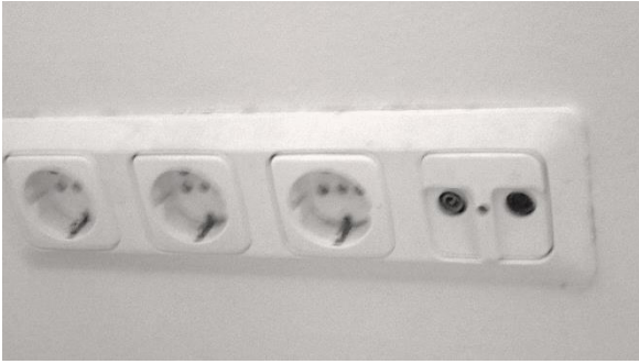
Kuva 45: Maadoitettuja pistorasioita yhteistiloissa. TV- ja radioantennipistokkein
