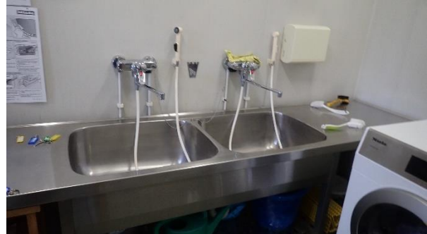
Kuva 20: Tuvan pesualtaat ja alkuperäiset vesihanat
