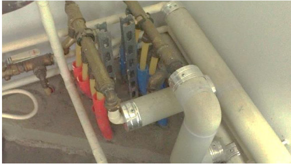
Kuva 30: Vesijohtojen jakotukki.
