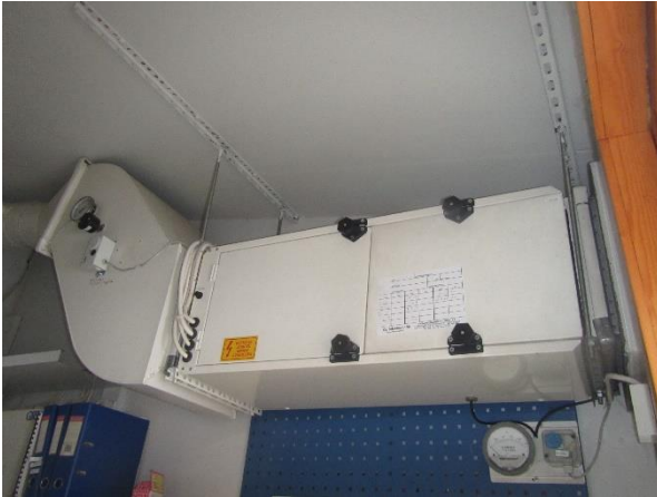
Kuva 37 Huoltorakennuksen tuloilmalaite
