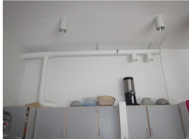
Kuva 18: Huoltorakennuksen ehteistiloissa on kaappi- ja säilytystiloja sekä kalusteita.
