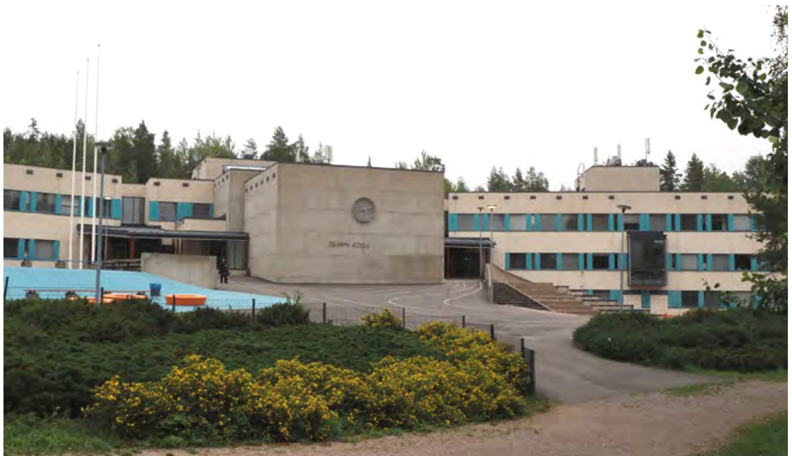
Kuva: Koulu välituntipihan puolelta kuvattuna. (Lähde: Rakennushistoriaselvitys, Ark-byroo 2024)
