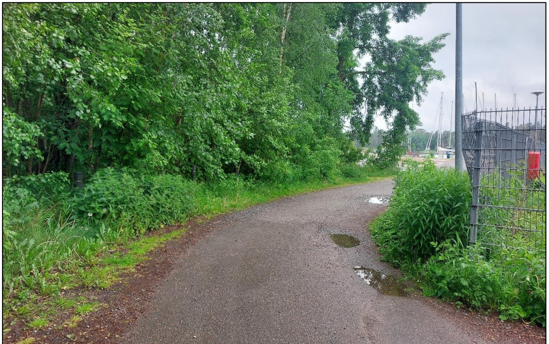
Huoltotie niemen kärkeen venelaitureille kulkee Meripelastajien aidatun alueen viereltä. Huoltotie säilytetään. Se palvelee myös kävelijöitä.
